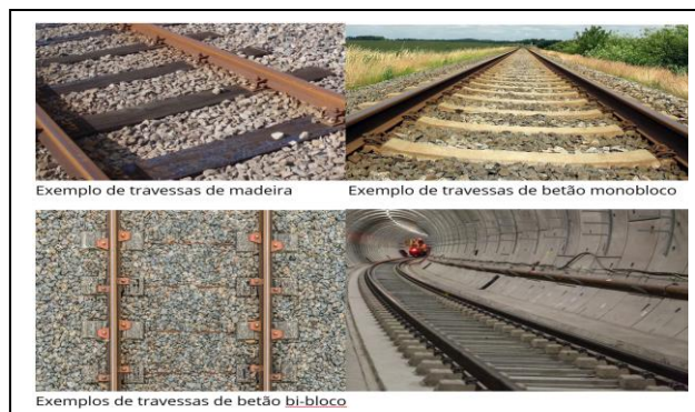
Figura 1 – Exemplos de travessas de betão e madeira
